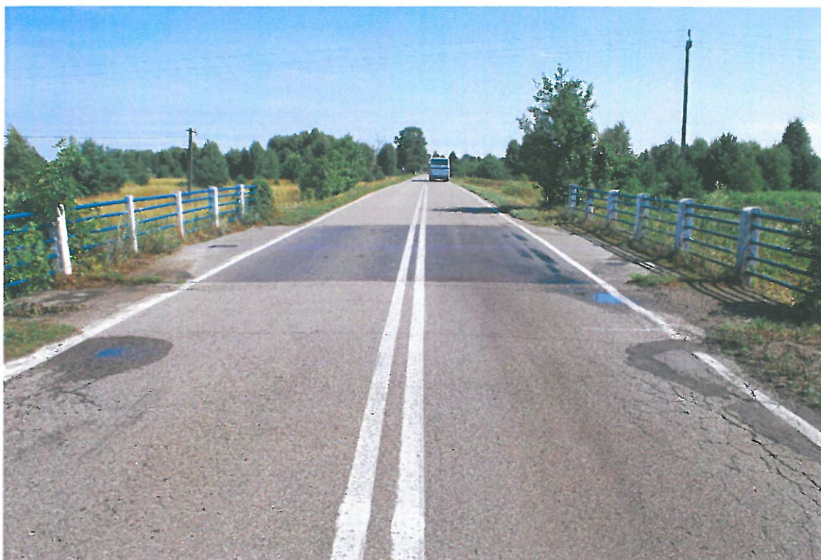
Fot. 1. Widok od strony południowej
