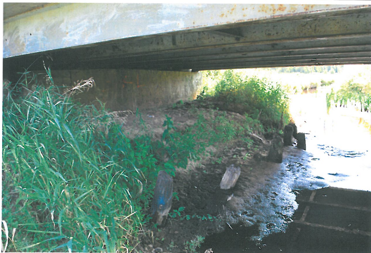
Fot. 24. Wegetacja roślin oraz przemieszczenia gruntu przestrzeni podmostowej – widok od strony północnej.
