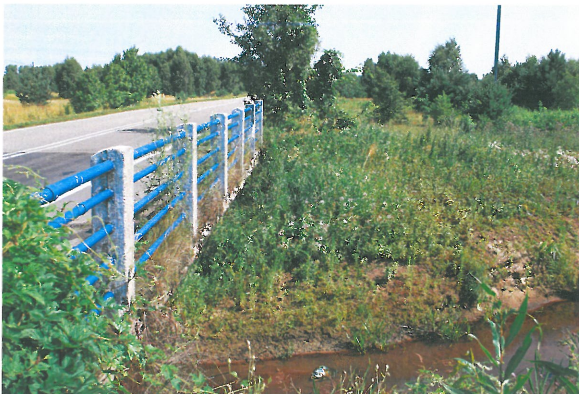
Fot. 5. Wegetacja roślin oraz zanieczyszczenia stożka spowodowane brakiem systematycznych prac utrzymaniowych - stożek od strony północnej i górnej wody.
