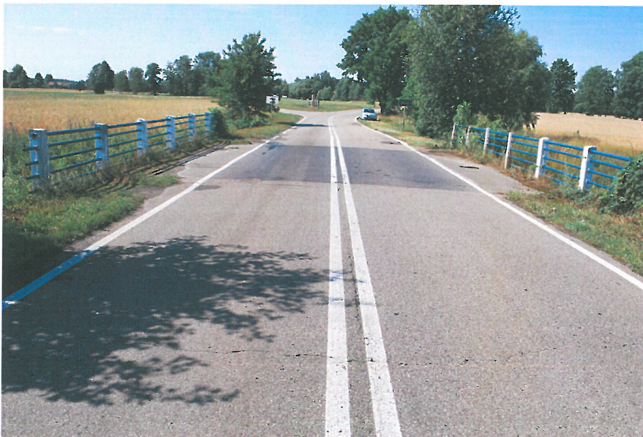
Widok ogólny mostu
